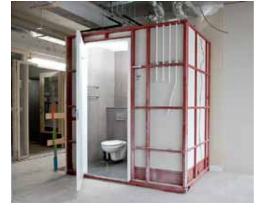
Früher Büro, bald Studentenwohnheim: In „The Student Hotel“ wurden vorgefertigte Bäder eingebaut.
